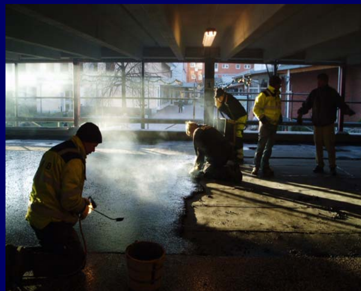
Läggning av gjutasfalt med inblandning av vax vid temperatur +230 grader
